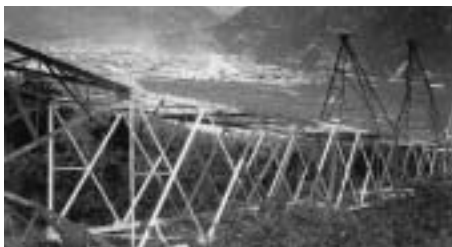
Nach der Feuernacht 11./12. Juni 1961: Gesprengte Strommasten (rechts).
